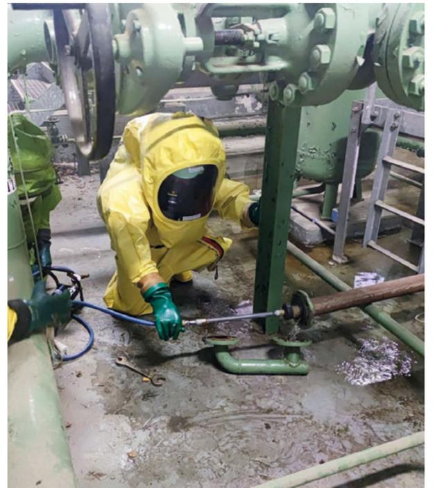
Abdichten einer Leckage an einer Rohrleitung: Die Einsatzkräfte arbeiteten bei ihrer Übung auch in sogenannten Chemikalienschutzanzügen.
