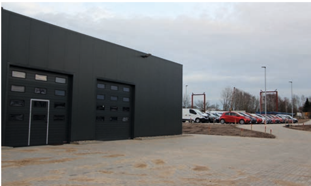
Auf dem neuerworbenen Grundstück sind eine neue Montagehalle sowie Stellplätze für Neu- und Jahreswagen entstanden (Foto: red).
