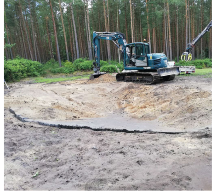
Einsatz mit schwerem Gerät: Der Tümpel für die Turteltauben entsteht 2022 auf einer rund 850 Quadratmeter großen Fläche am Rand einer Heidelbeerplantage.
