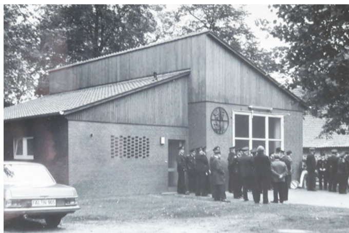
Aus Garage wird Feuerwehrhaus: Am 18. Oktober 1980 wird das neue Gerätehaus in Häuslingen feierlich in Betrieb genommen.
