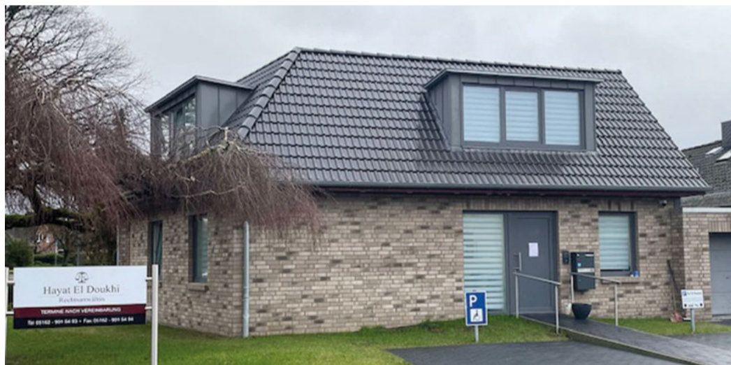
Nach einer Bauzeit von 18 Monaten ist für die Rechtsanwaltskanzlei El Doukhi ein ansprechender Zweietagenanbau entstanden, ausgestattet mit modernster Büro- und Überwachungstechnik. Foto: A.W. Pütz
